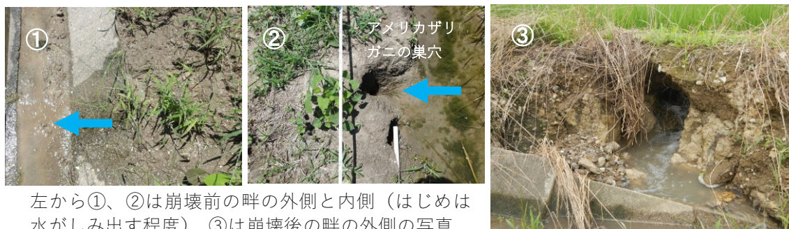
図3 アメリカザリガニの巣穴による畔の崩壊事例（写真：愛知県農業総合試験場提供）
