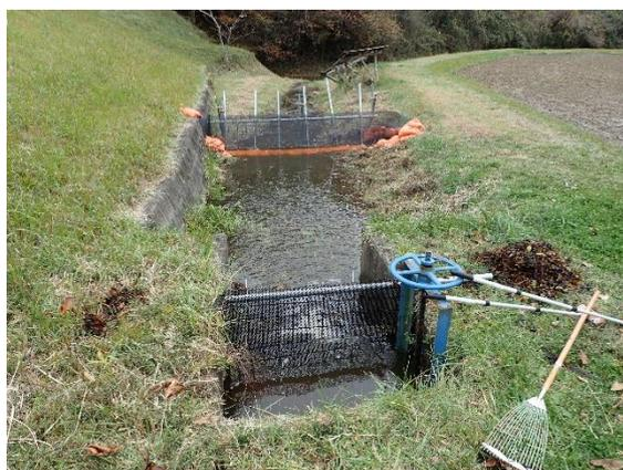
写真1 流下防止網の設置状況
