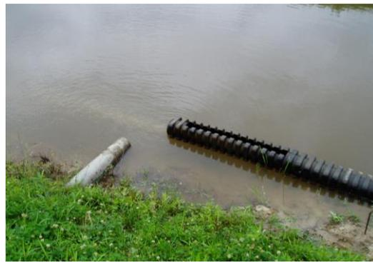
魚道の下流端が水中に沈んだ様子（左）と，下流端を水面上に浮かせた様子（右）
